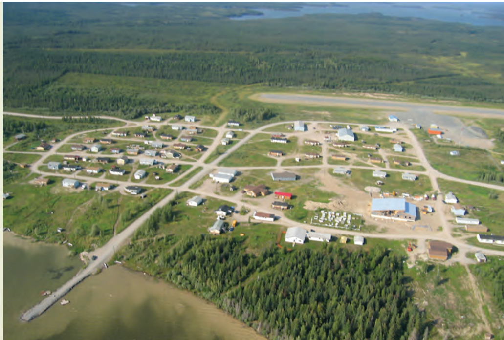
York Landing (Kawechiwasiq).
